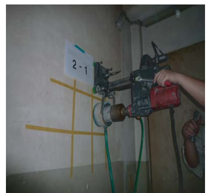
①ダイヤモンドカッターを使用しコアを採取する。
