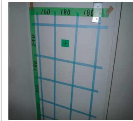
③コンクリートコア採取箇所の決定。
