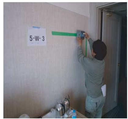
①コンクリート内の鉄筋、配管等を超音波探査器を使用し調査する。
