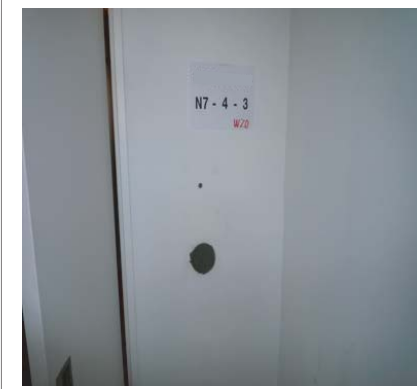
②採取後、モルタルを充填し補修する。
